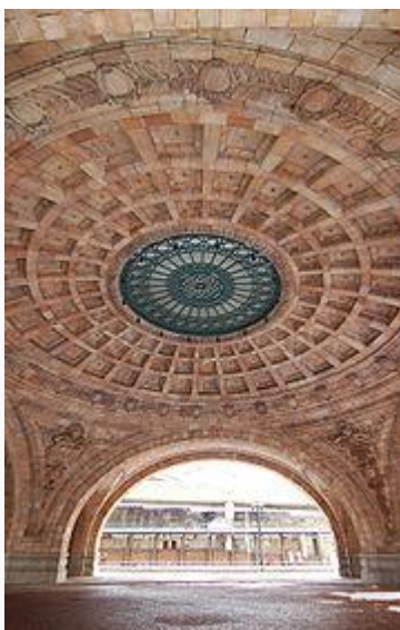
Bóveda de la Union Station en Pittsburgh .
