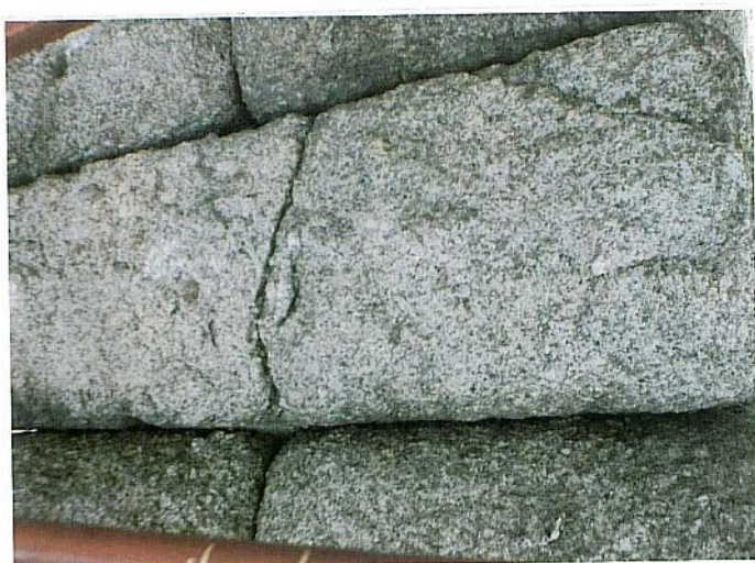
En muchos casos, una grieta que se ha iniciado justo sobre una junta entre sillares inferiores, acaba dividiendo el sillar en dos partes muy meteorizadas. (Fotografías originales de 19x12,5 c.m. del propio autor).
