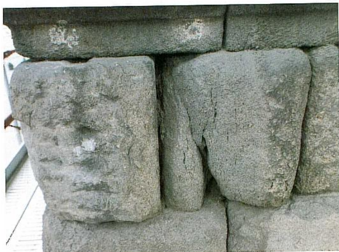
En muchos casos, una grieta que se ha iniciado justo sobre una junta entre sillares inferiores, acaba dividiendo el sillar en dos partes muy meteorizadas. (Fotografías originales de 19x12,5 c.m. del propio autor).
