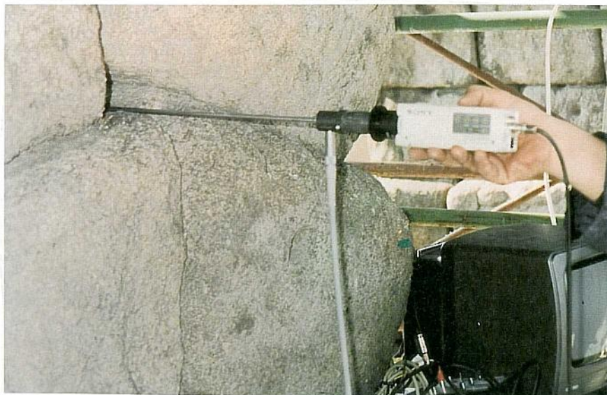
Endoscopio utilizado para inspeccionar el interior de las pilas entre los sillares. (Fotografía cedida por GEOCISA).
