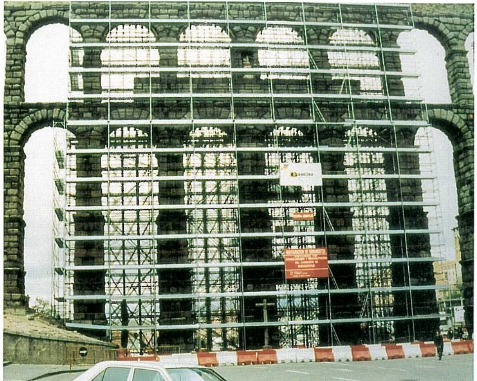
Andamio colocado en julio de 1992 como medida preventiva y como medio de dar accesibilidad para el estudio y la inspección detallada de la zona del sotobanco. (Fotografía proporcionada por la empresa GEOCISA).
